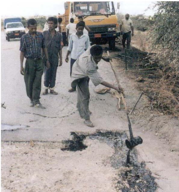
Fig.4 : Point-à-temps artisanal en 97 à Madagascar. Quand les budgets d'entretien courant sont gravement insuffisants, pour des trafics généralement confidentiels, un dispositif de suivi du réseau trop lourd et trop cher n'a aucune chance de perdurer.
